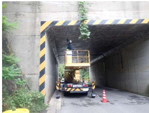
写真 3-1 大型カルバートの点検状況
