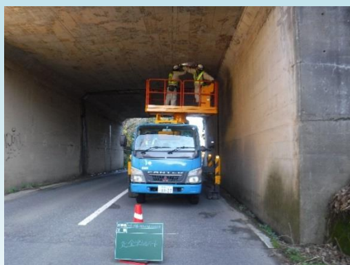
高所作業車による点検
