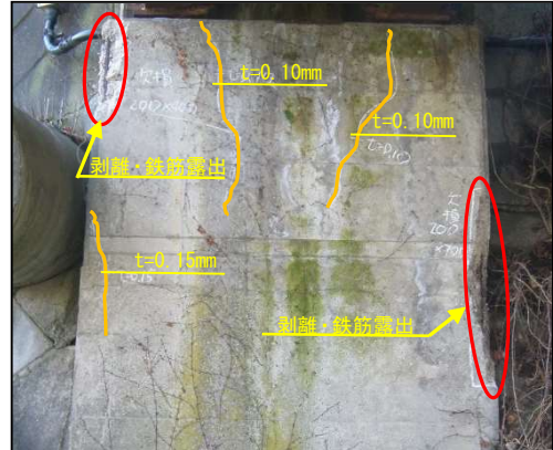
縦壁部のひび割れ、鉄筋露出
