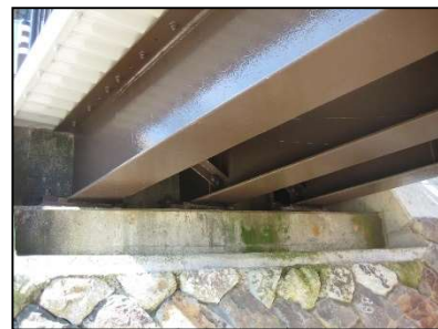
【補修後】主桁端部
