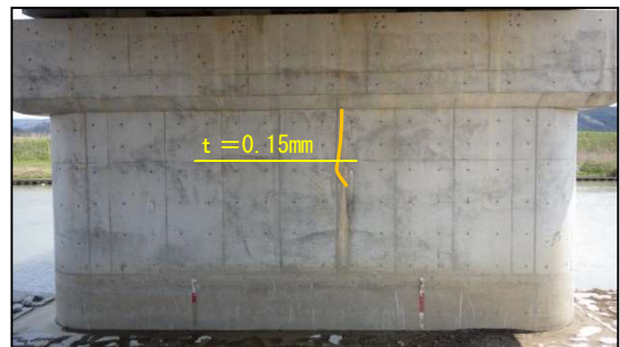
橋脚柱部のひびわれ
