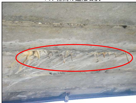
PCI 桁間の遊離石灰
