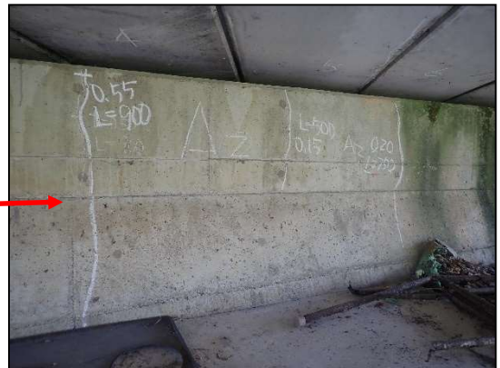
縦壁部のひび割れ、漏水
