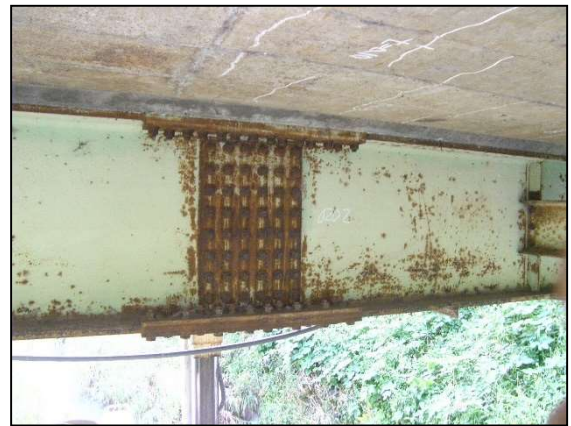
主桁添接部の腐食
