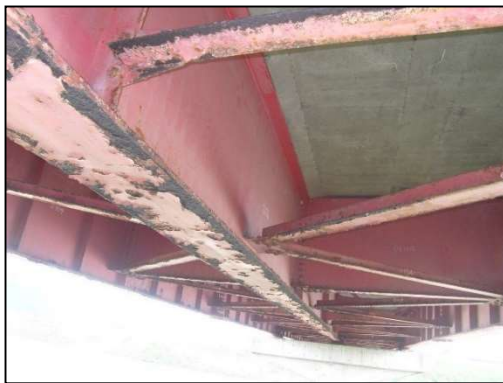
【補修前】主桁等の腐食
