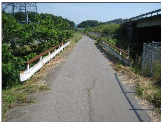
【補修前】防護柵全景 (最小約 75cm)
