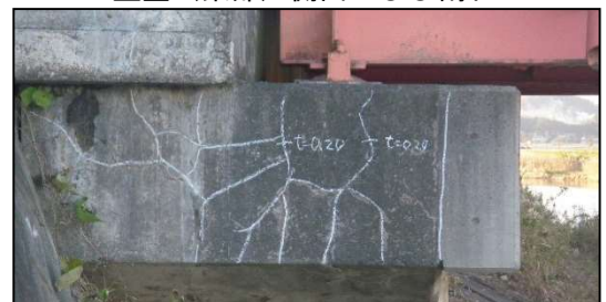
縦壁（梁部）側面のひび割れ
