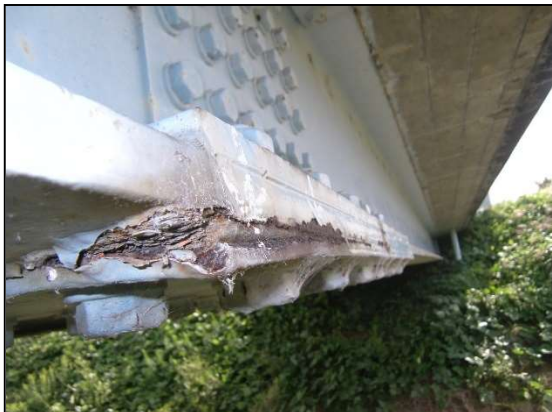
【補修前】主桁添接部の腐食
