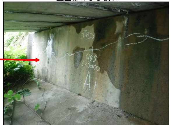
堅壁部のひび割れ
