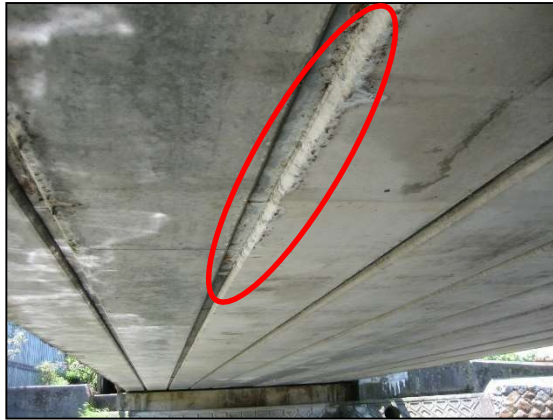
全景 & 主桁間の遊離石灰
