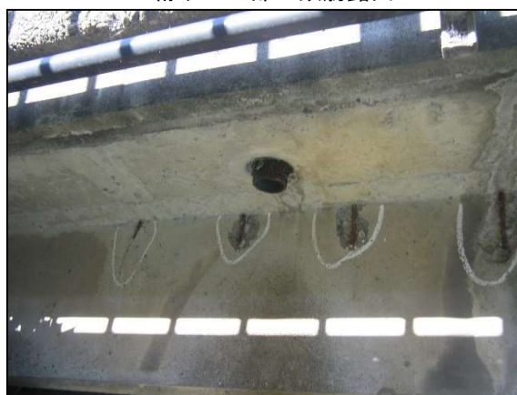
PC 桁ウェブ部の鉄筋露出
