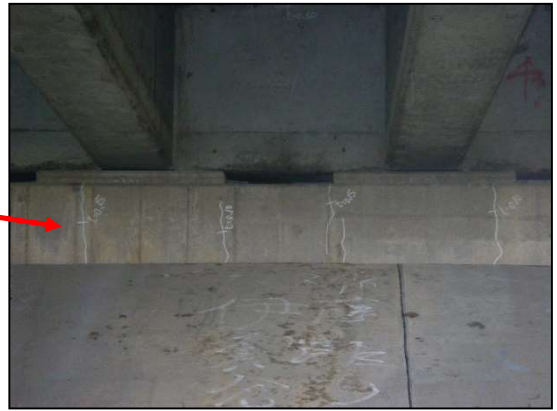
縦壁部のひび割れ
