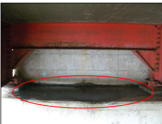
主桁端部の漏水環境
