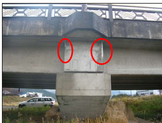
PC 桁端横桁部の遊離石灰
