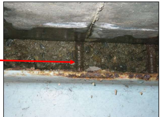
胸壁部の鉄筋露出
