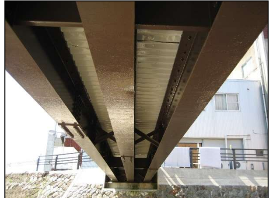
【補修後】主桁端部
