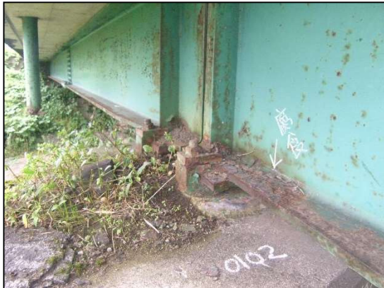
【補修前】主桁端部（橋脚上）の腐食
