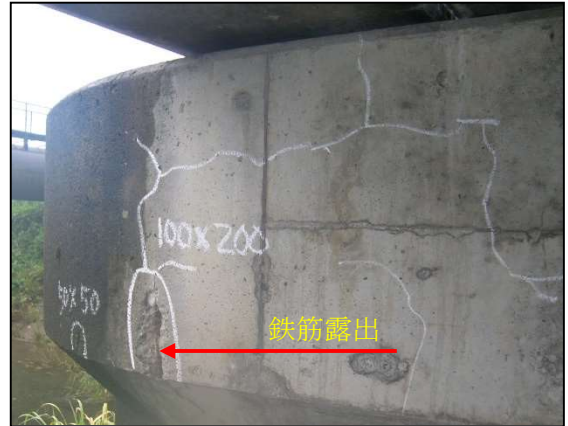
橋脚梁部のひび割れ及び鉄筋露出
