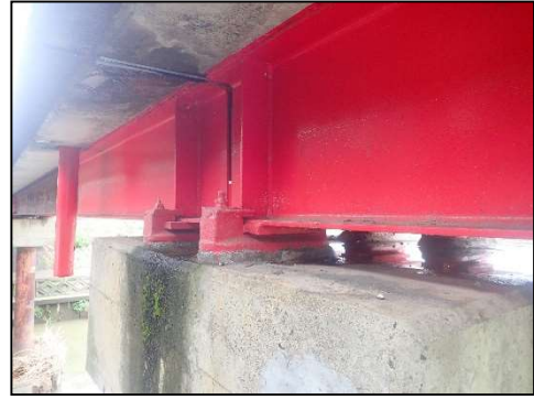
【補修後】主桁端部（橋脚上）の腐食
