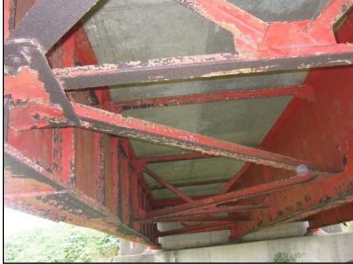
【補修前】主桁等の腐食
