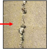
柱部の鉛直方向のひび割れ
