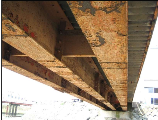
【補修前】主桁端部
