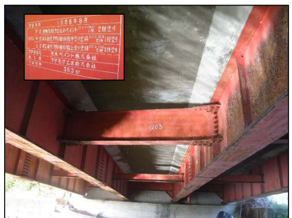
主桁・横桁の腐食
