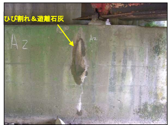
縦壁にひび割れ、遊離石灰
