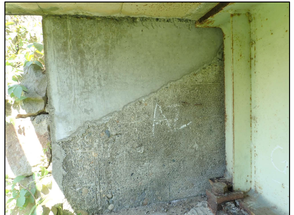
胸壁部のひび割れ
