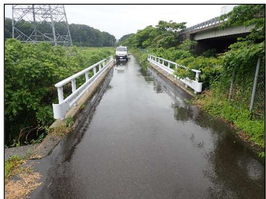
【補修後】防護柵全景 (110 cm)
