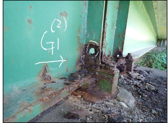
主桁端部の腐食
