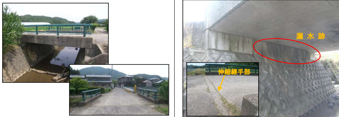
伸縮装置の損傷（坂尻橋）
