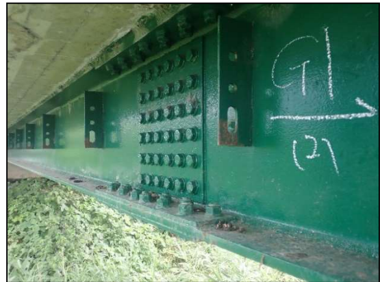
【補修後】主桁添接部の状況
