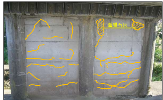
充填壁部にひび割れ
