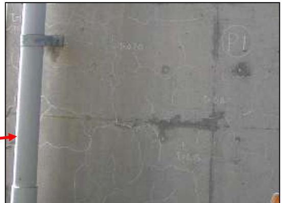
橋脚柱部のひび割れ
