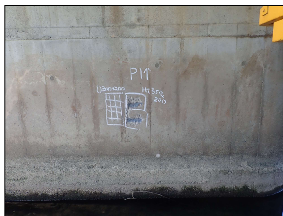
橋脚柱部・壁部の剥離・鉄筋露出、うき
