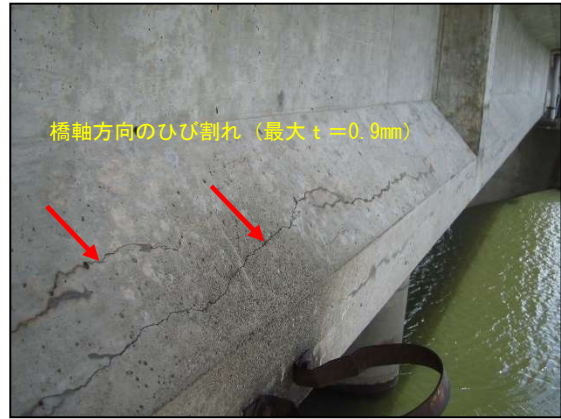
PCボーステンT桁（外桁）に発生したひび割れ
