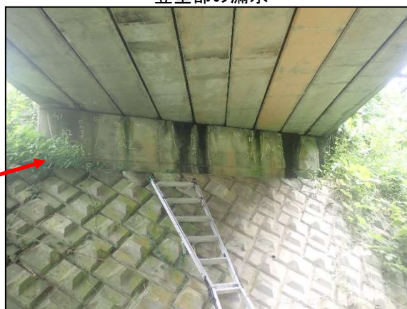
縦壁部の漏水
