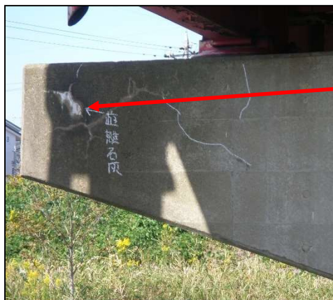
橋脚梁部の遊離石灰を伴うひび割れ
