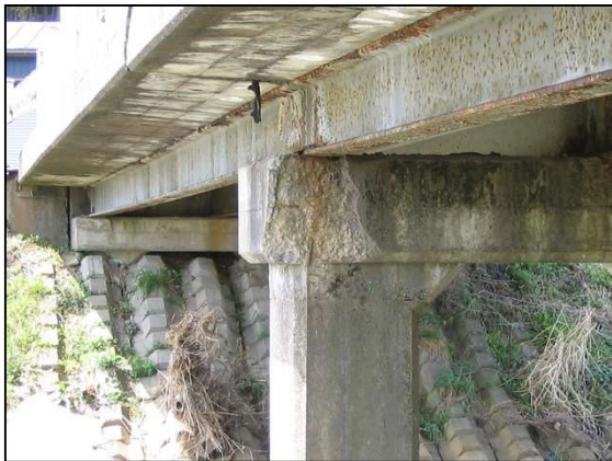
【補修前】主桁（外桁）
