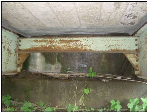
主桁端部の漏水環境
