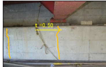
縦壁部のひび割れ
