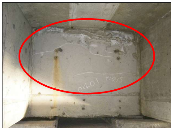
橋台端横桁部の遊離石灰&ひび割れ
