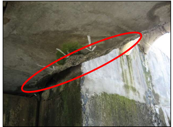
外桁に損傷
