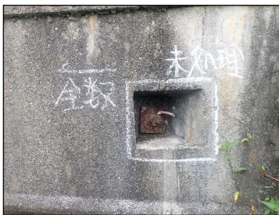
後埋めコンクリートの未処理
