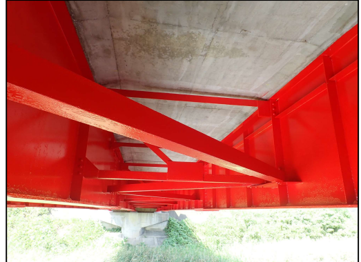
【補修後】主桁等の状況
