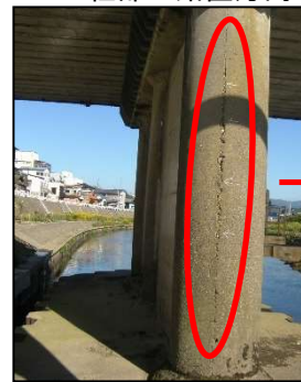
柱部の鉛直方向のひび割れ
