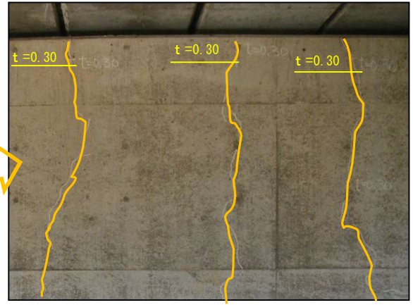
堅壁部のひび割れ
