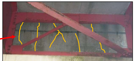
縦壁（梁部）側面のひび割れ
