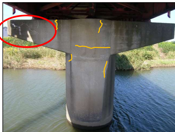
橋脚全景および梁・柱部のひび割れ
