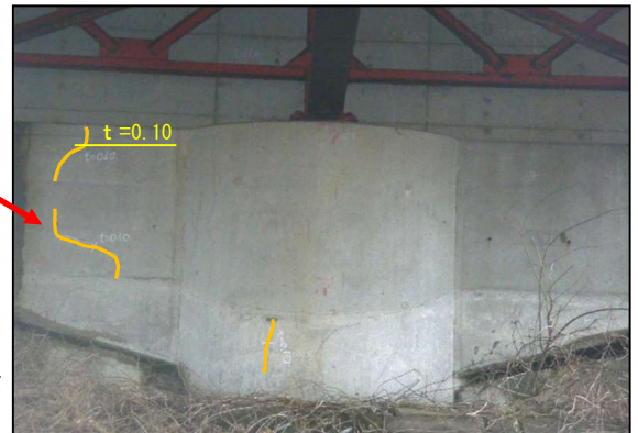
縦壁（梁部）のひび割れ
