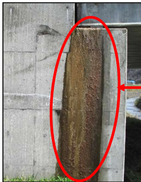
堅壁側面部の漏水
