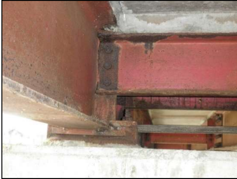
【補修前】主桁端部（橋脚上）の腐食
