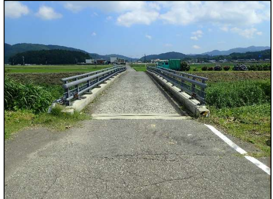
【補修後】防護柵全景 (110 cm)
