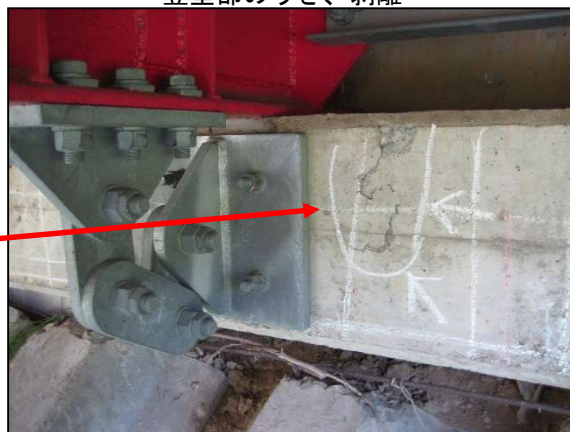
縦壁部のうき、剥離
