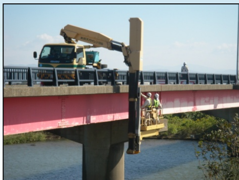
橋梁点検車による点検
