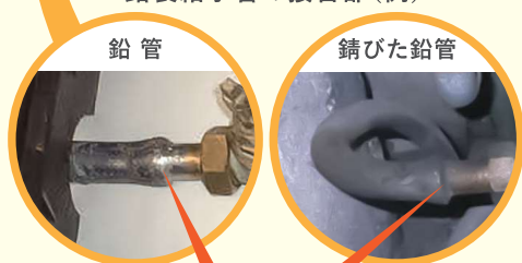
鉛製給水管の接合部(例)
