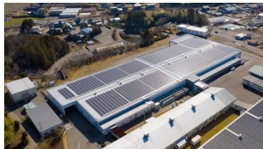
屋根置き太陽光 (福井鋌螺 細呂木事業所)
