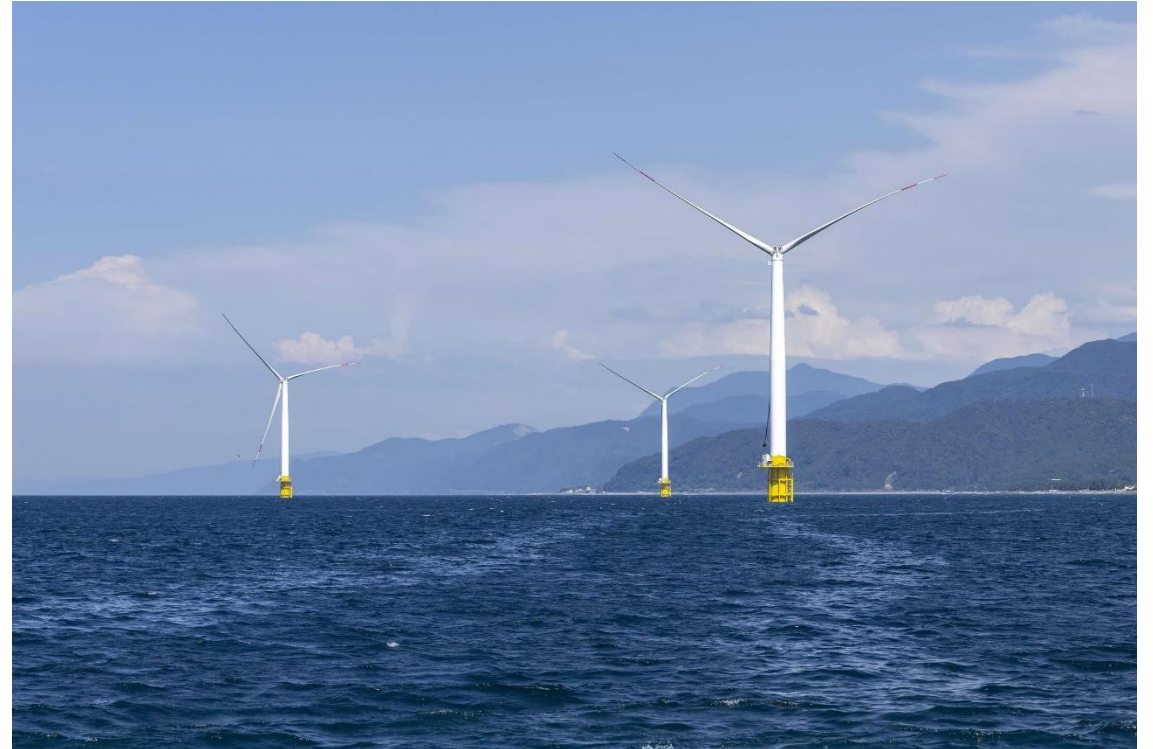
入善洋上風力発電所
