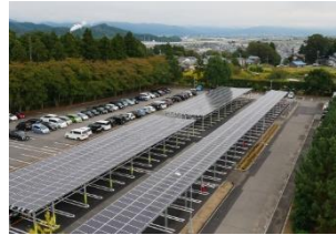
ソーラーカーポート (金津村田製作所 クリーンエネパーク)
