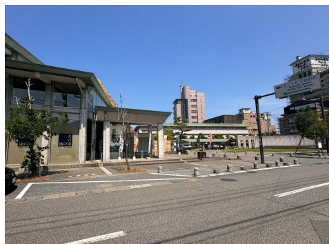
セントピアあわらは地域に向けてひらけた「総湯」としての役割を担えるように感じる。広場は整備されているが、セントピアあわらや他の主体による広場の活用は乏しい。
