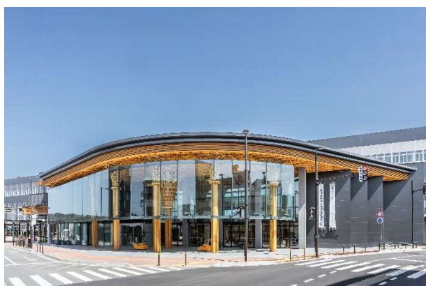
JR 芦原温泉駅西口賑わい施設「アフレア」
