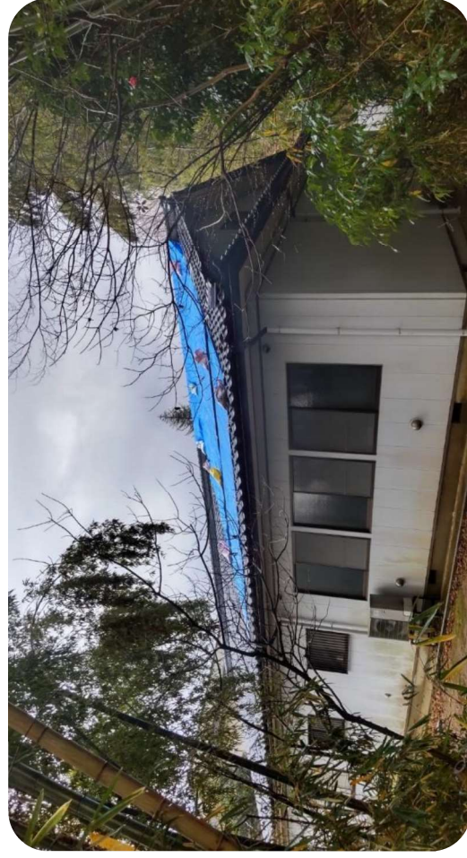
北側屋根現状
