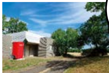
多目的グラウンド南側トイレ付近
