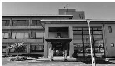
▲改修予定の中央公民館
