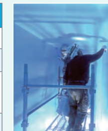
▲内面防水工事の様子
