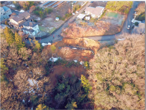
▲ 下金屋で市道が崩落した現場
