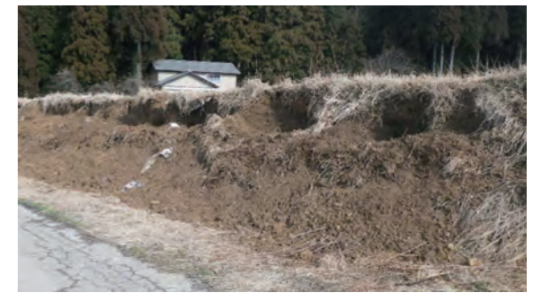
▲イノシシに掘り起こされた水田の土手
