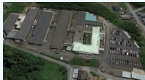
▲現在の施設全景航空写真
