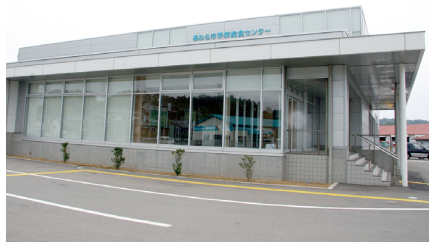
学校給食センター蒸気発生器入替工事 6,270 万円
