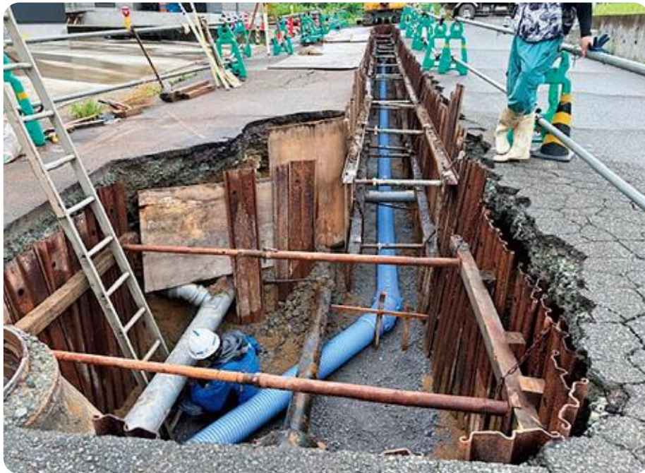
下水道管整備の様子
