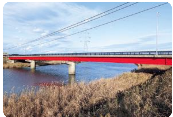
市内にある橋りょう（水屋橋）
