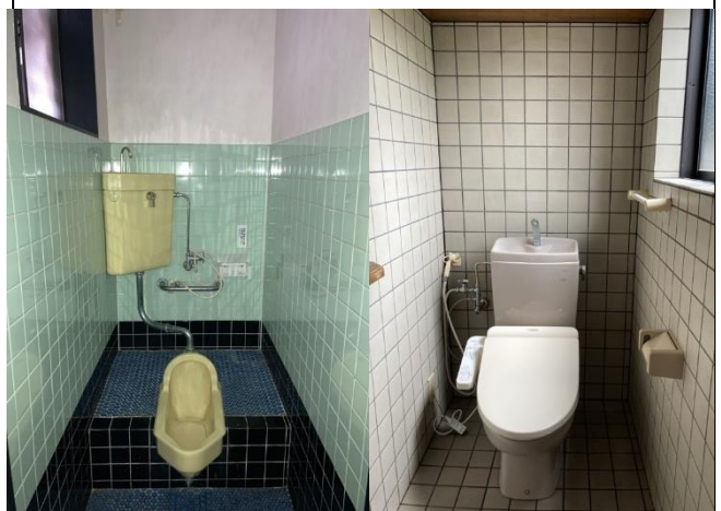
内部（店舗部分）
