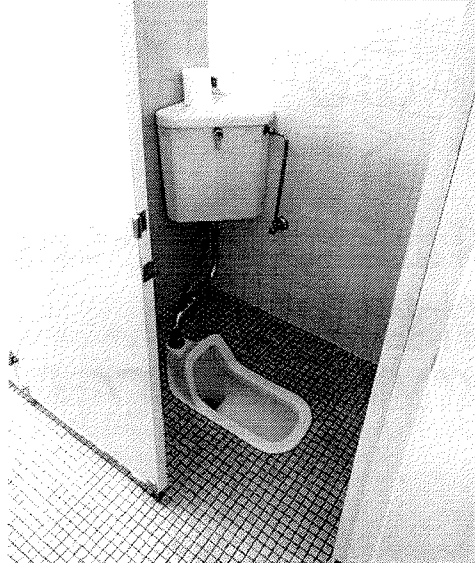
①1階、2階、渡り廊下のトイレ
