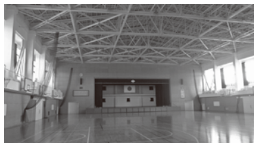
▲空調設置予定の中学校体育館
