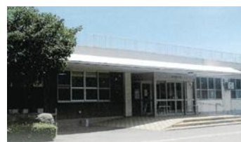
▲ 照明設備を改修する金津雲雀ヶ丘寮
