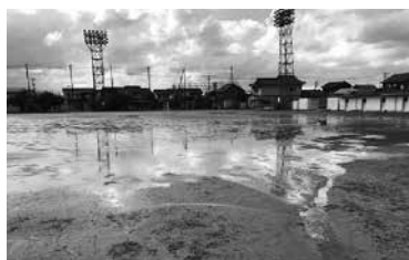
▲金津中学校グラウンドの降水後の状況
