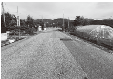
市道修繕予定箇所
