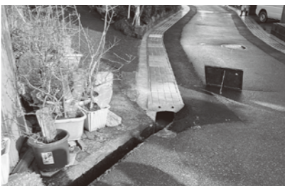
門型側溝整備
