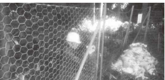
金網固定柵整備(清滝区)
