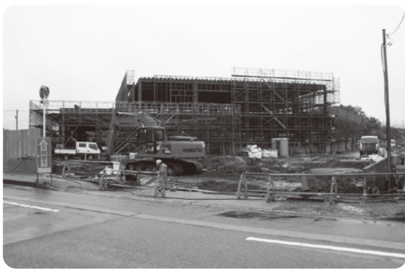
建設中の学校給食センター
