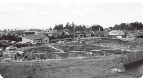
建設中の学校給食センター
