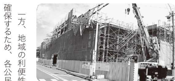
改築中の（仮称）生涯学習館
