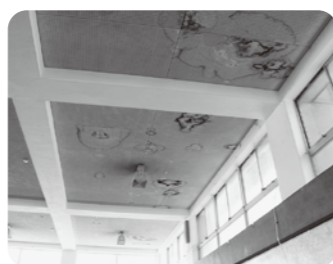
武道館の天井
