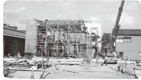
移設作業中の藤野徹九郎記念館
