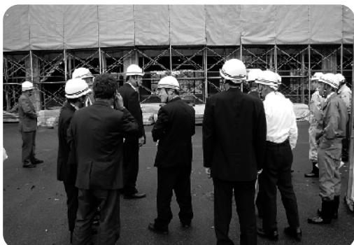
複合福祉施設(旧芦原庁舎)改修工事
