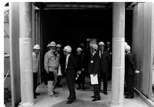
金津中学校(渡り廊下)耐震改修工事
