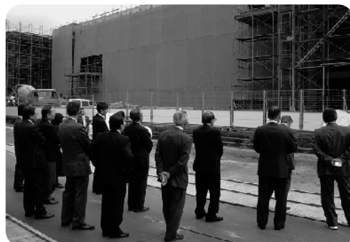
芦原中学校北校舎耐震改修工事
