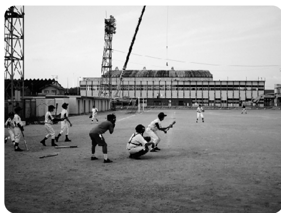
仮設校舎を建設中の金津中学校
