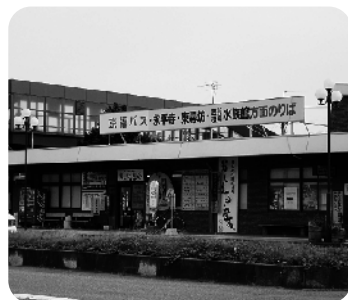
改修を待つ あわら湯の町駅舎
