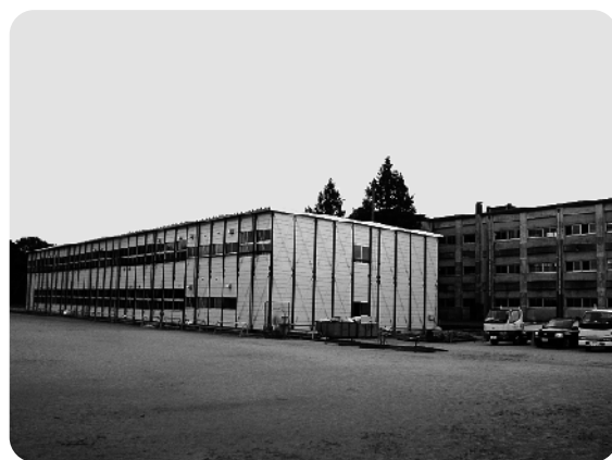
仮設校舎を建設中の芦原中学校
