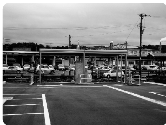
整備された芦原温泉駅前の西口駐車場
