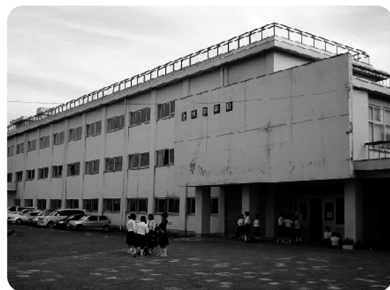
改修工事間近の金津中学校北校舎
