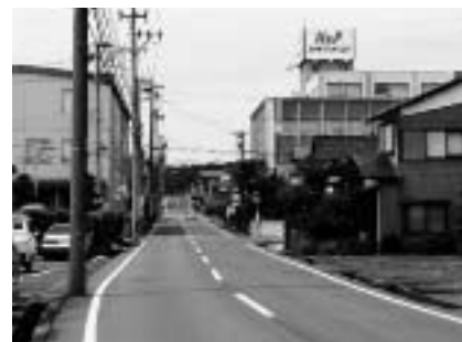
市道旭・山室線の融雪設置予定地
