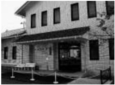
市内の集会施設（浜坂区）
