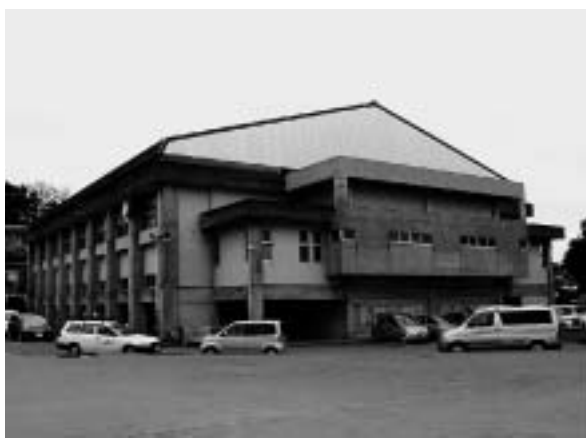
金津小学校体育館
