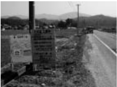
坪江地区の下水道工事
