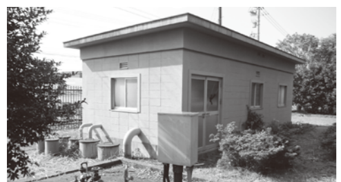
工業用水道事業ポンプ場
