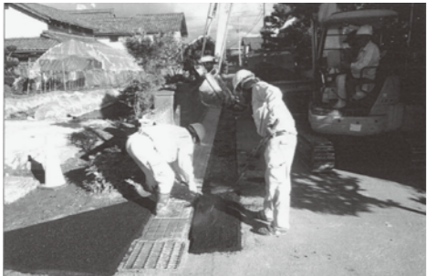
門型側溝整備
