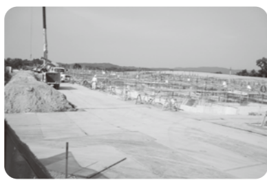
建設中の芦原青年の家
