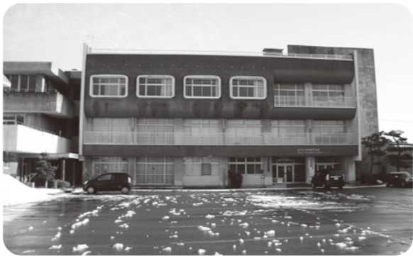
解体を検討している社会福祉センター
