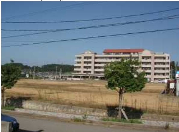
駐車場(市営)東口駐車場
