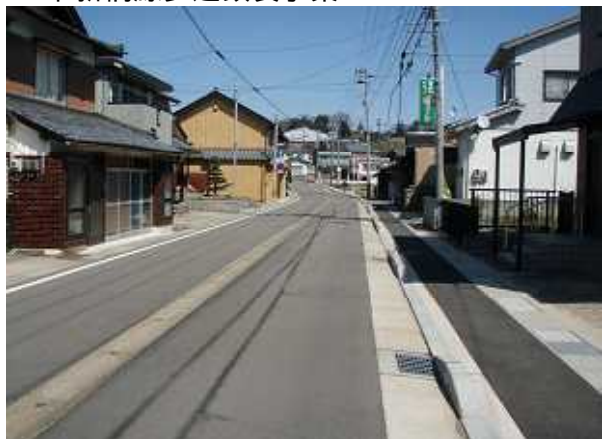
下新橋線歩道改良事業 L=116m
