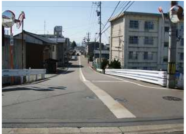
市道旭・山室線消雪事業 L=604m
