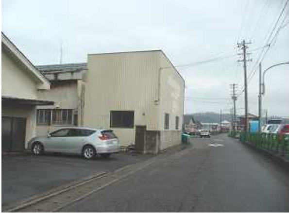
市道105号線改良事業
