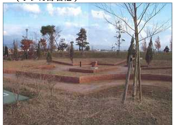
クレヨンランドかなづ設備工事 (レンガ縁石他)
