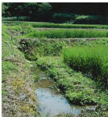
“ぬるめ”などと呼ばれる、水を温めるための水路
