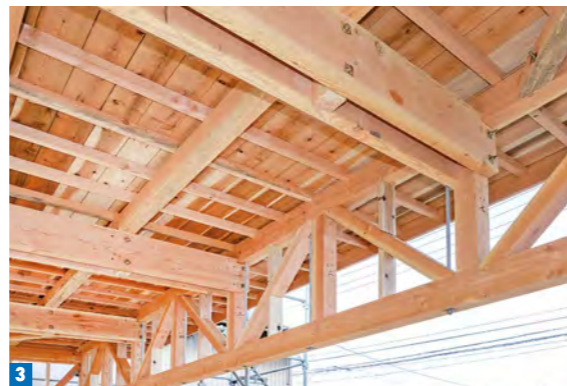
1 創業60年以上の技術と経験を注ぎ込んで作業が進む木造車庫の建築現場 2 第一建設が手がけ2021年5月に完成した「芦原温泉駅西口立体駐車場」 3 木造で大空間を実現するため職人の手刻みで仕上げられた「トラス梁」や「合わせ梁」
