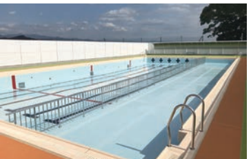
▲金津小学校のプール工事事業に活用
