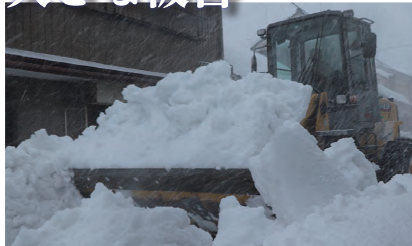
吹雪の中での除雪作業
