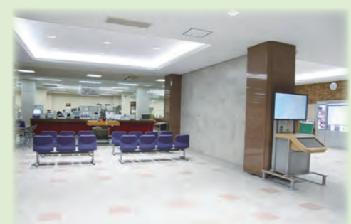
▲1階ロビーに耐震壁を設置
