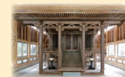
▲本荘春日神社本殿(県指定文化財・建造物)
