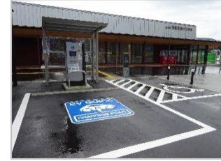
ハートフル対応型駐車マスを整備 (恐竜溪谷かつやま EV 充電スタンド)
