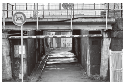
市道831号線アンダーパス
