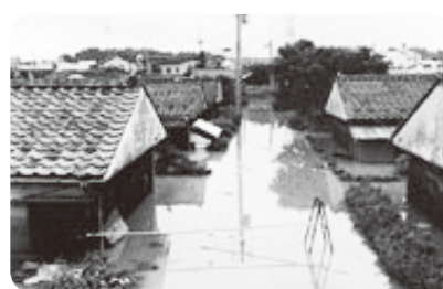
金津町営住宅浸水(S56.7)
